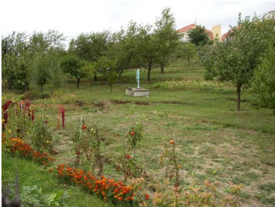
Obr. 2: Zátřhy sesouvající se zeminy byly patrné i výše po svahu na parcelách soukromých vlastníků
